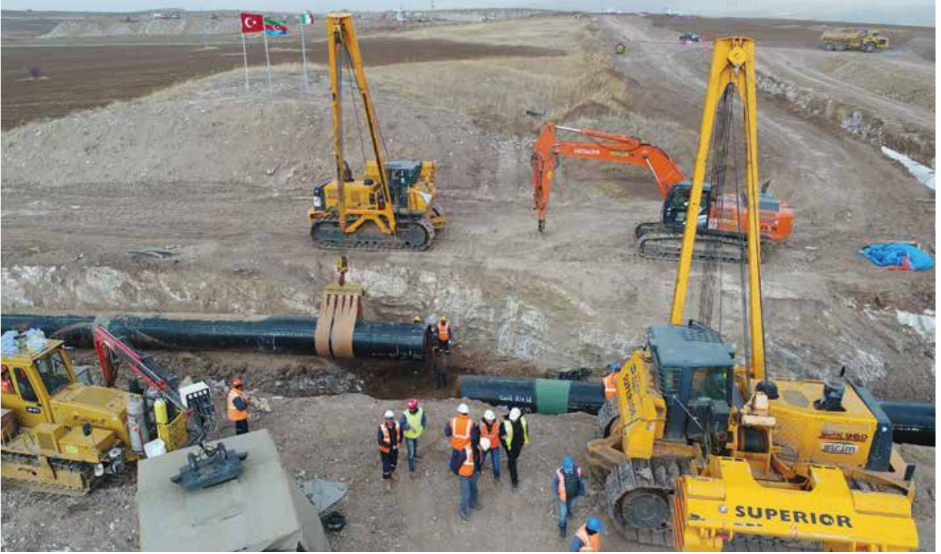
Trans Anadolu Doğalgaz Boru Hattı Projesi'nin (TANAP) Lot 2 inşaatı Yüksel İnşaat A.Ş.
