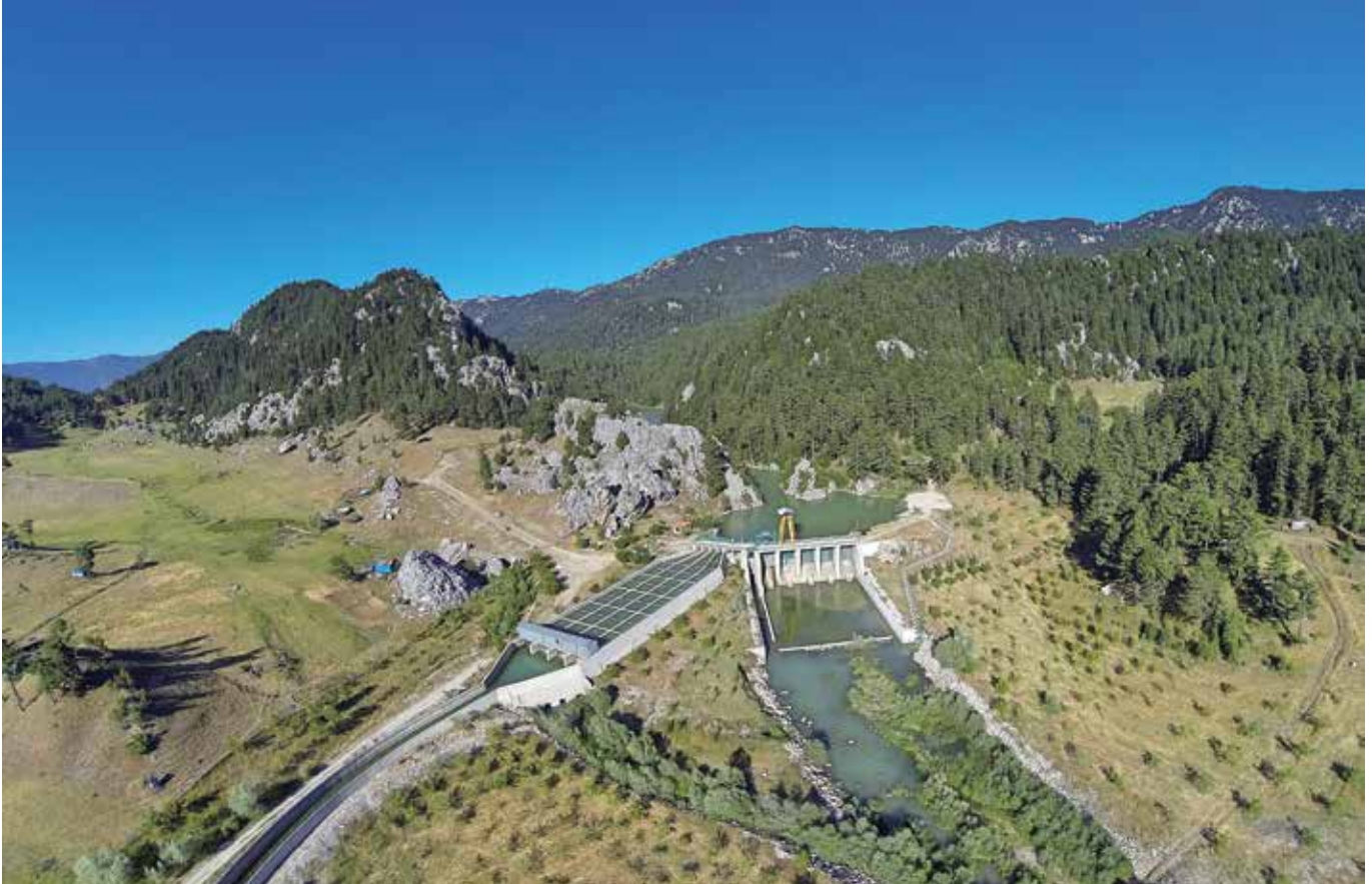
Değirmenüstü HES, Kahramanmaraş, Gülsan İnşaat A.Ş.
