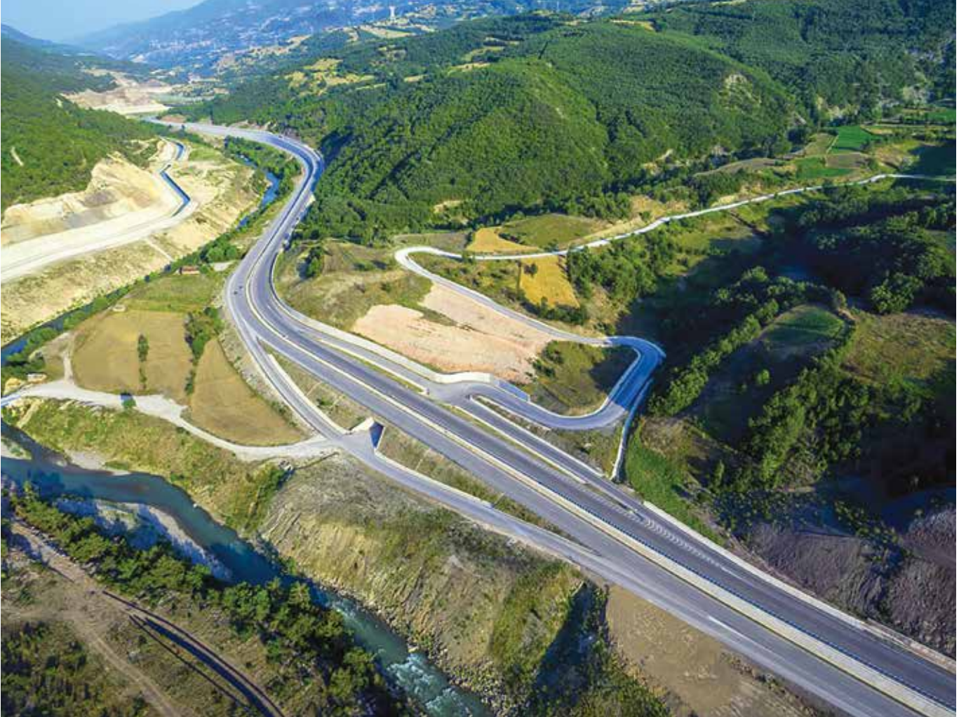
Erbaa-Reşadiye Yolu, Ösak İnşaat A.Ş.
