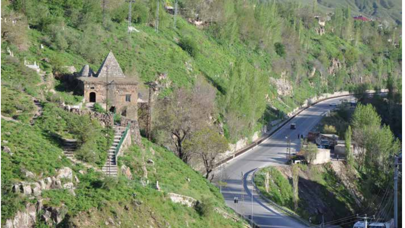
Bitlis Hacı Hasan Türbesi Ve Diyarbakır Yolu
