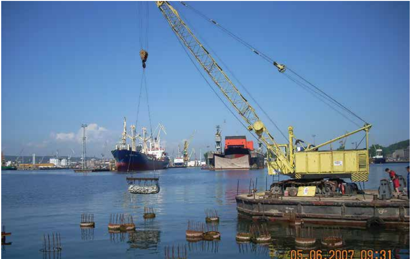
Gdynia Askeri Deniz Üssü Rihtım Yenileme Polonya, Yenigün İnşaat A.Ş.
