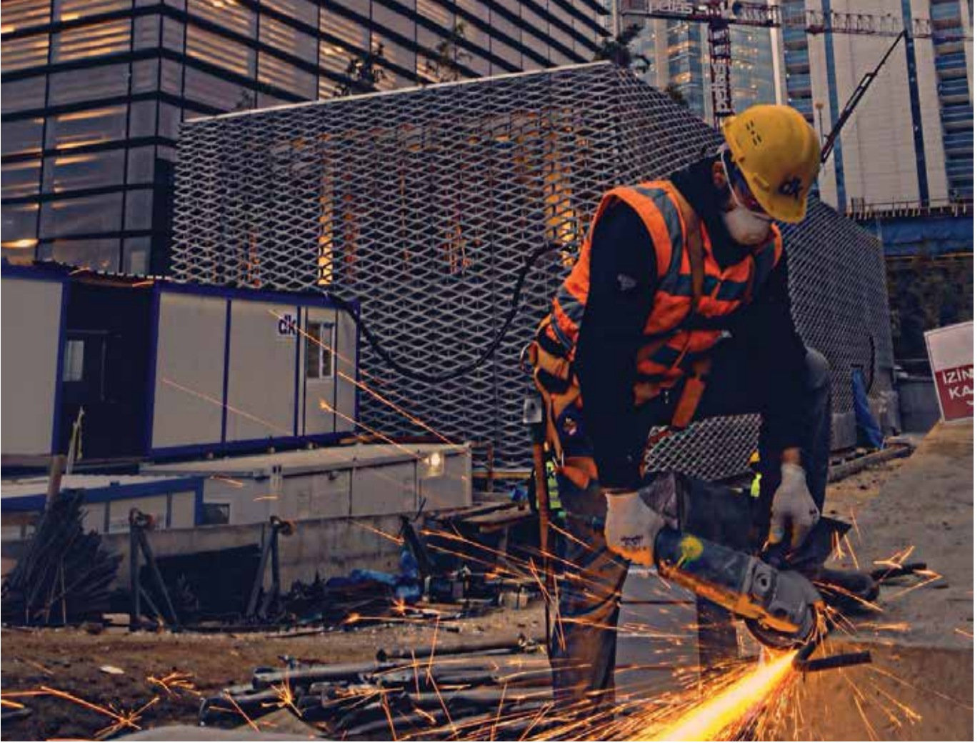
Capitol Vista, DVK İnşaat A.Ş.
