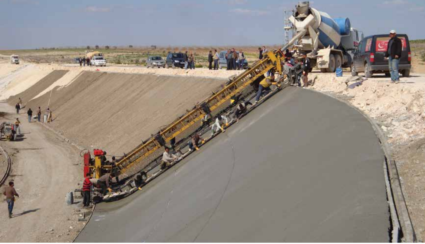
Belkıs Nizip Pompaj Sulaması, Gaziantep, Mehmet Güneş İnşaat A.Ş.
