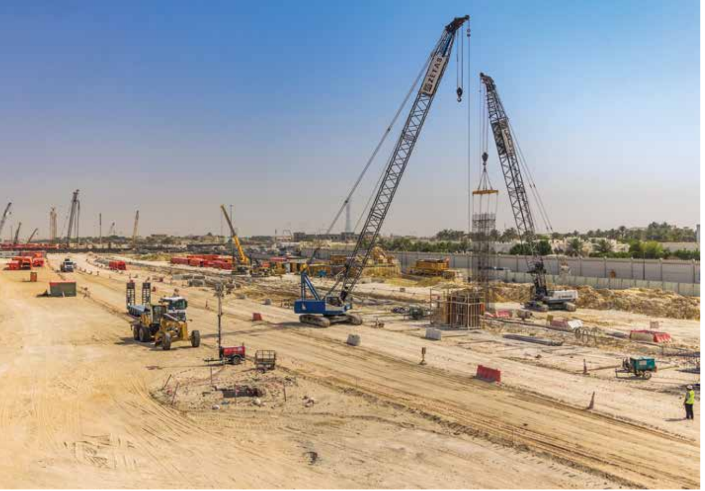
Katar Al Rayyan Yolu Yapımı ve İyileştirmesi, Dağuş İnşaat A.Ş.
