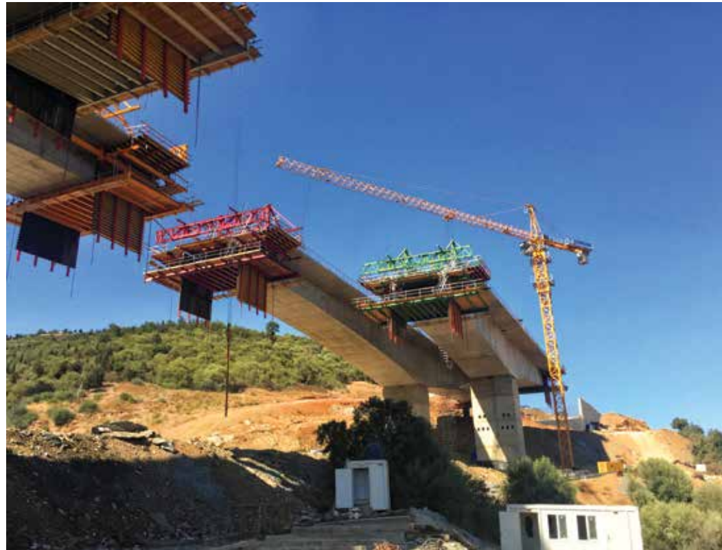
Tizi Ouzou Şehrini Djebahia Kavşağı Seviyesinde Doğu - Batı Otoyoluna Bağlayan 48 km Otoyol Yapım İşİ, Özgün İnşaat A.Ş.
