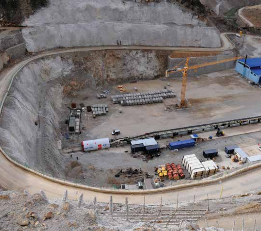
Bağbaşı Barajı ve Mavi Tüneli İnşaatı, İlci İnşaat A.Ş.
