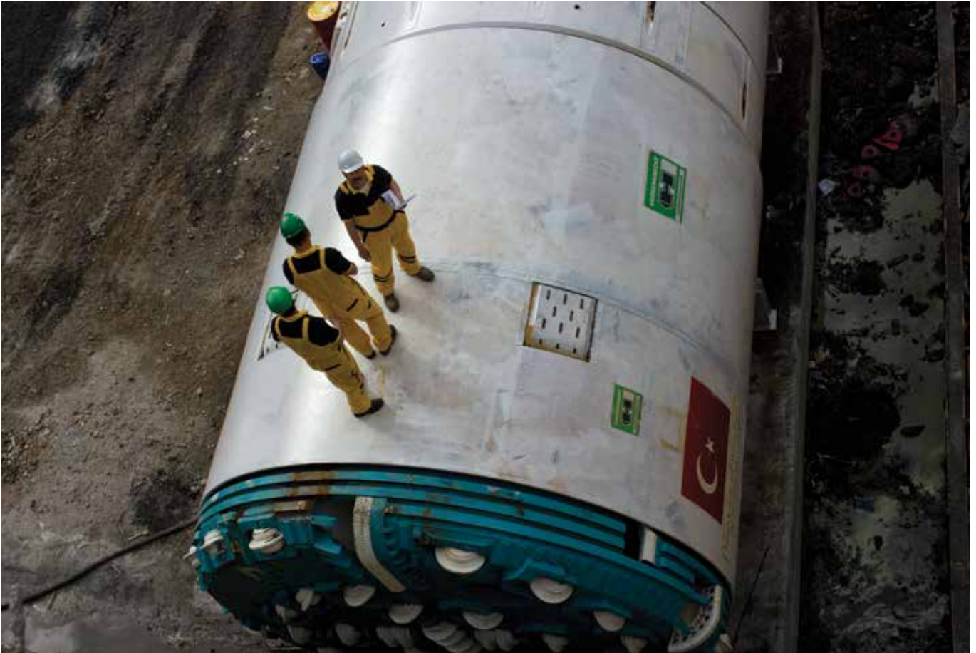
Ankara İçmesuyu 2. Merhale Projesi Gerede Sistemi İnşaatı, Kolin İnşaat A.Ş.
