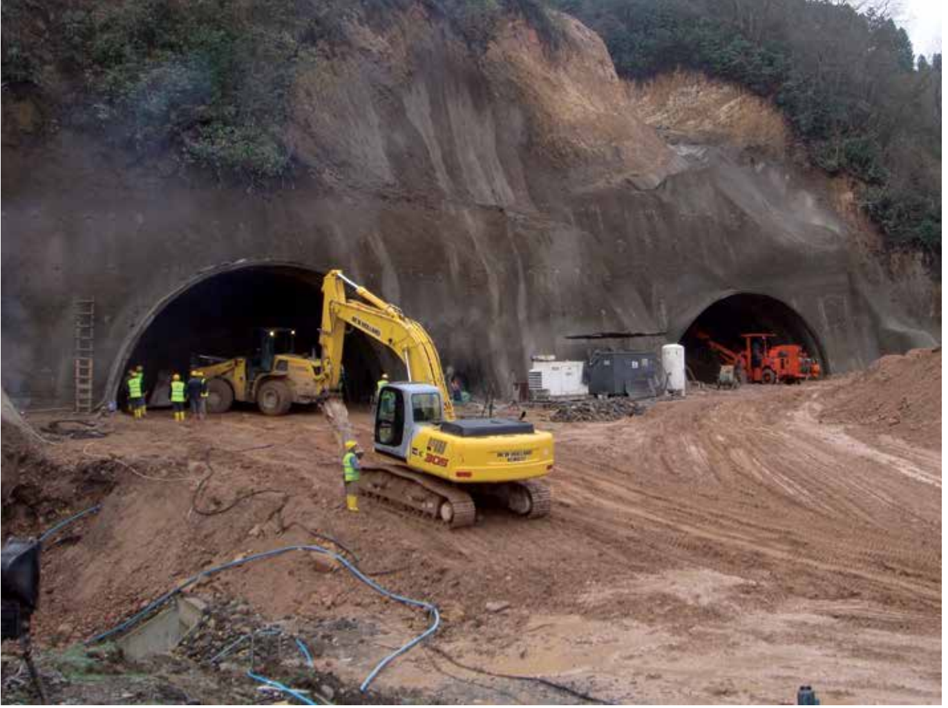
STY İnşaat Şantiye Sahası
