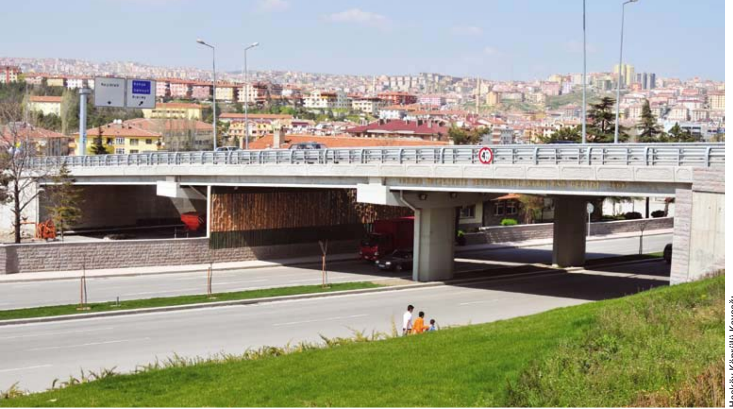
Hasköy Köprülü Kavşağı
