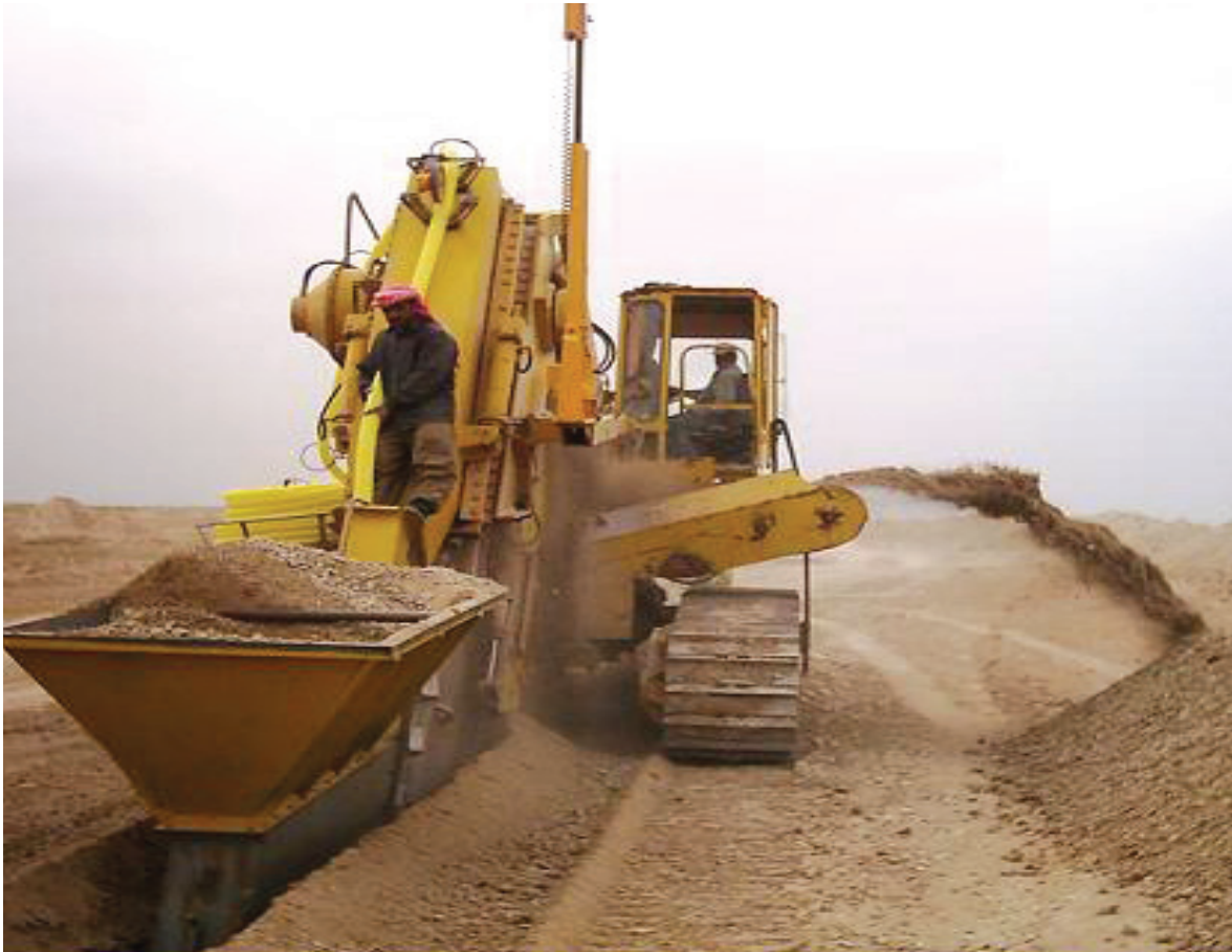
Al-Baleekh Sulama ve Arazi İslah Projesi Derin Drenaj Şebekesi İnşaatı, SURIYE
