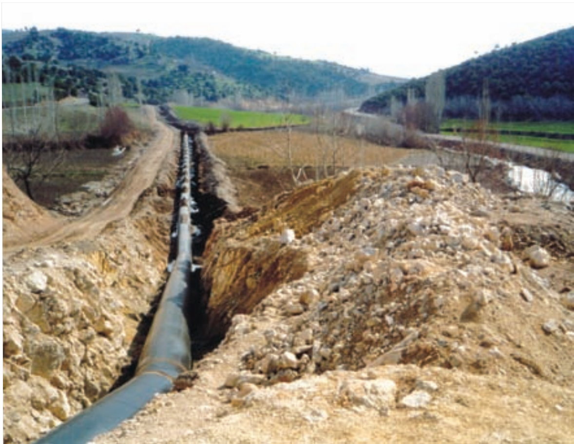
Ayvalı Barajı Ishale Hattı, KAHRAMANMARAŞ
