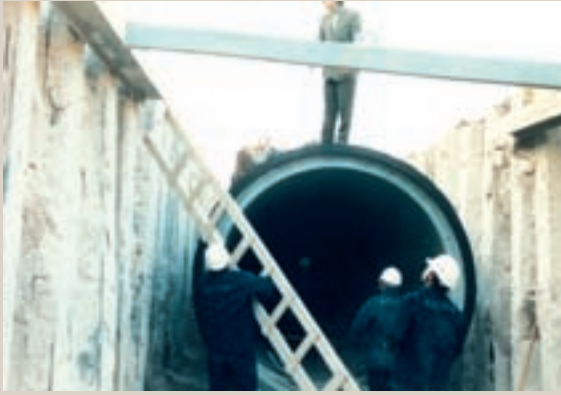
Adapazarı Kanalizasyon Projesi kollektör hattı inşaatı 2400mm betonarme boru
