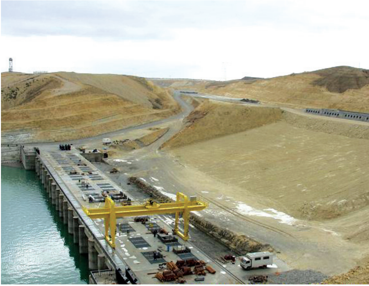
Belkız Pomba İstasyonu İnşaatı, Nizip / GAZİANTEP
