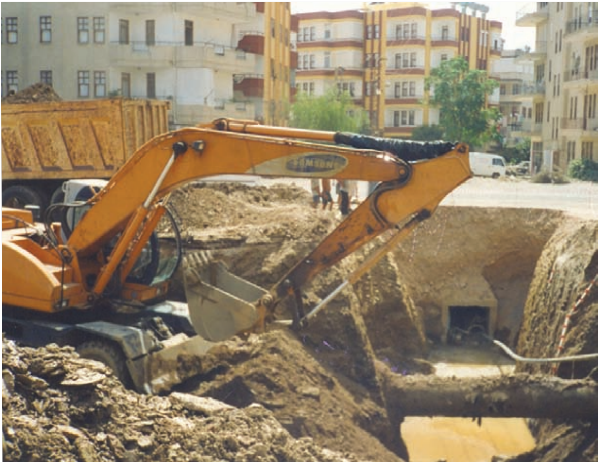
İller Bankası Alanya Kanalizasyon İnşaatı
