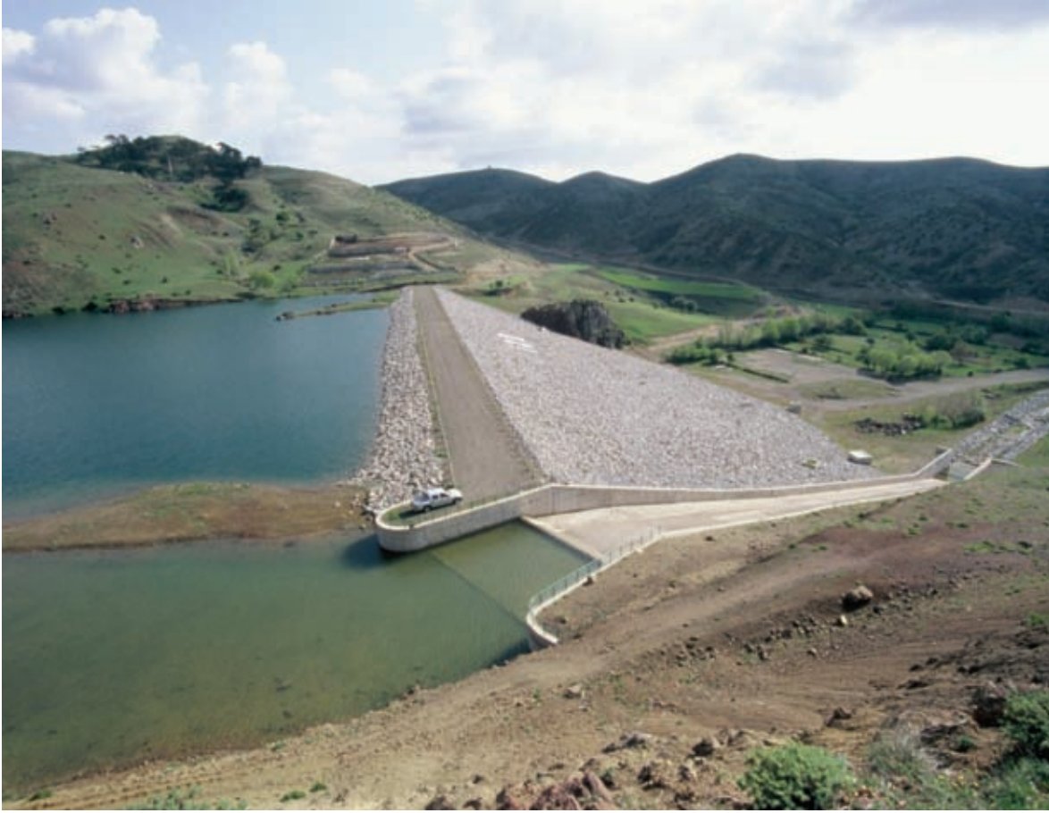
Hanköy Üççam Göleti ve Sulaması İnşaatı / ESKİŞEHİR
