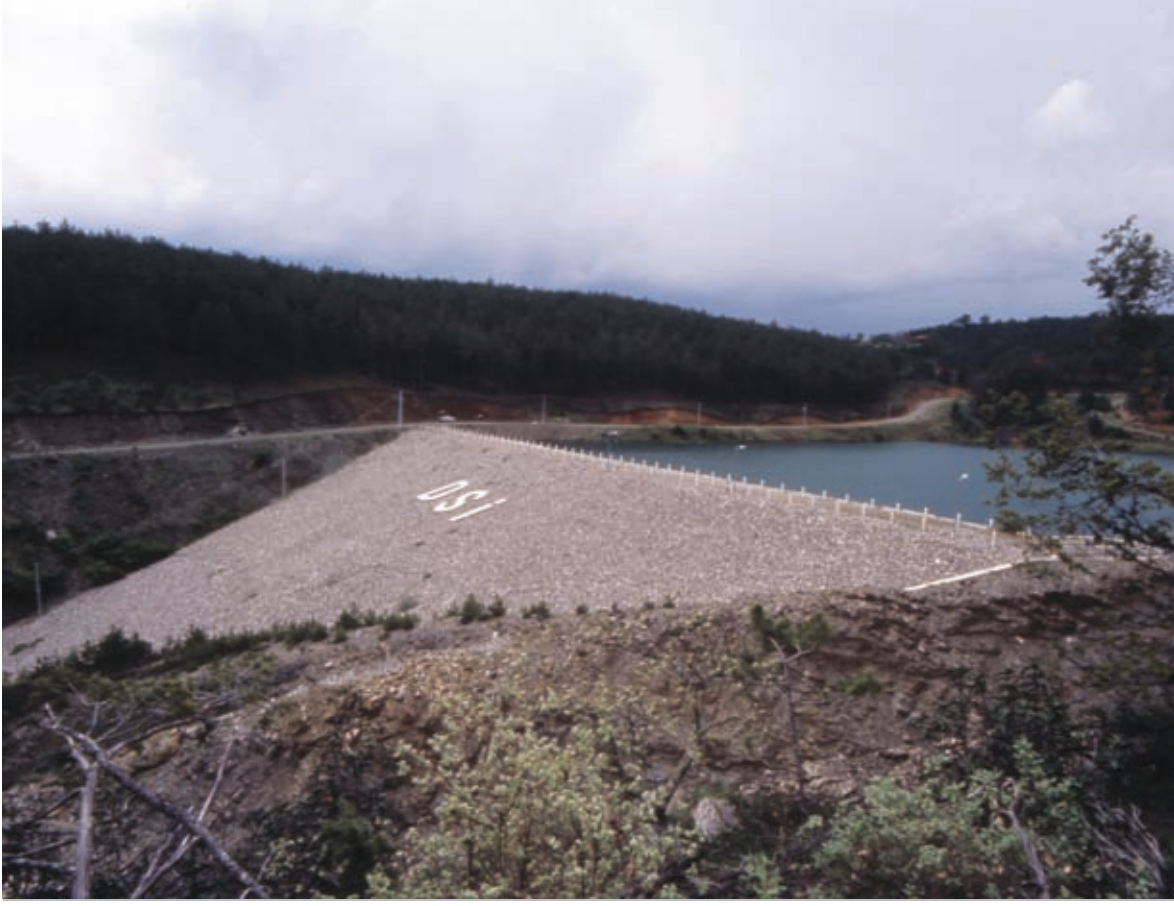
Çankırı Korgun Maruf Göleti ve Sulaması İnşaatı
