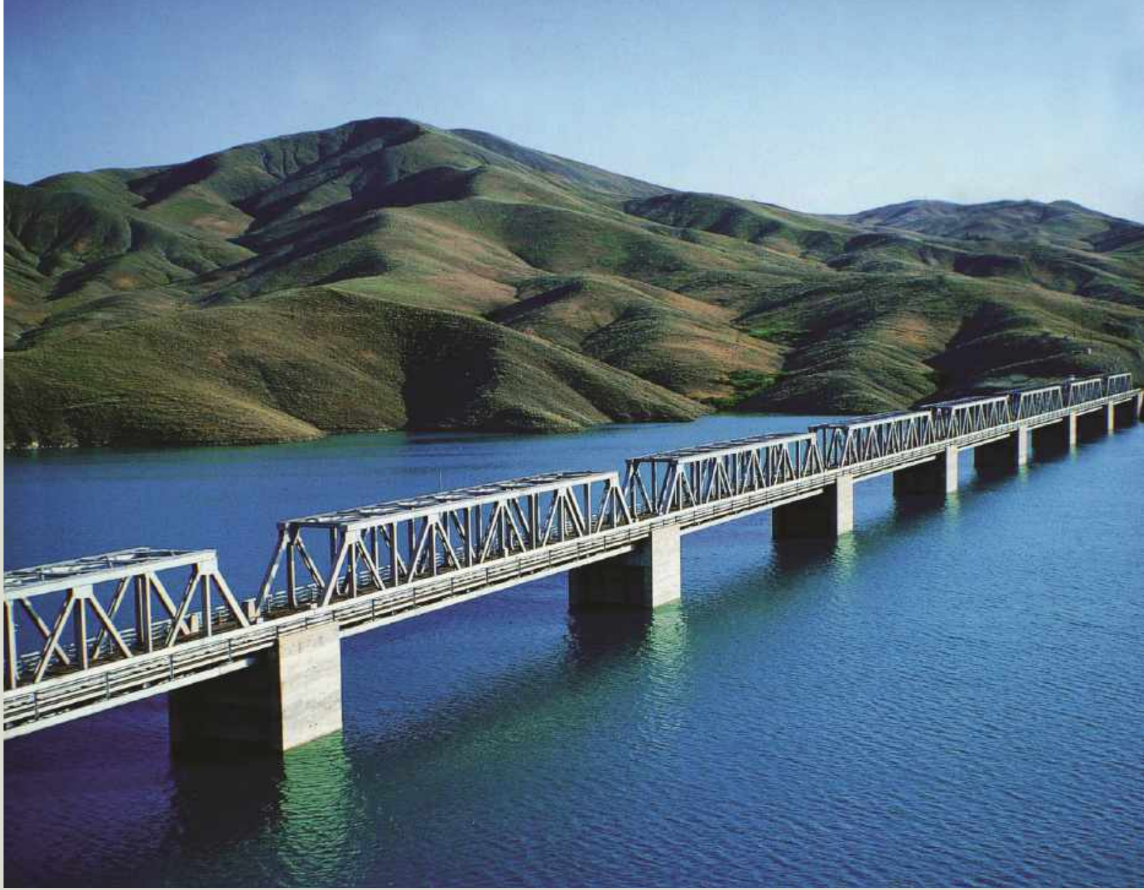
Karakaya Baraj Gölü Demiryolu Köprüsü
